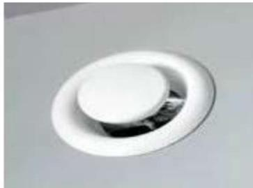
Les bouches d'entrée et d'extraction de l'air sont placées soit au sol, soit aux murs soit aux plafonds des différentes pièces (selon contrainte technique dans l'armoire recevant la VMC), suivant les indications du fabricant, de l'étude technique spécifique et des contraintes techniques de l'immeuble.
